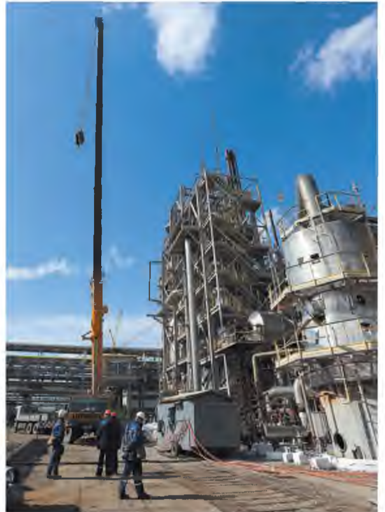
В отделении метанирования установили новый подогреватель питательной воды
