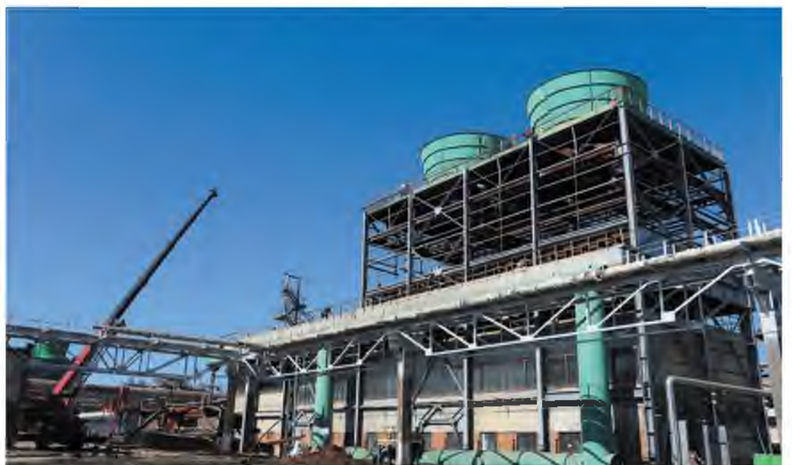
Установка будет обшита панелями из пластика, которые обеспечат герметичность
