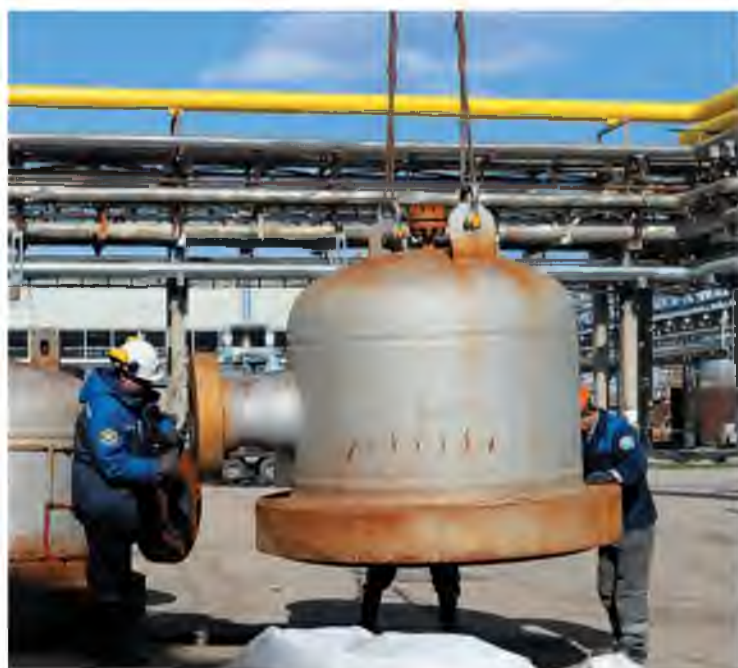
Цех №26 заменил два котла-утилизатора в отделении риформинга
