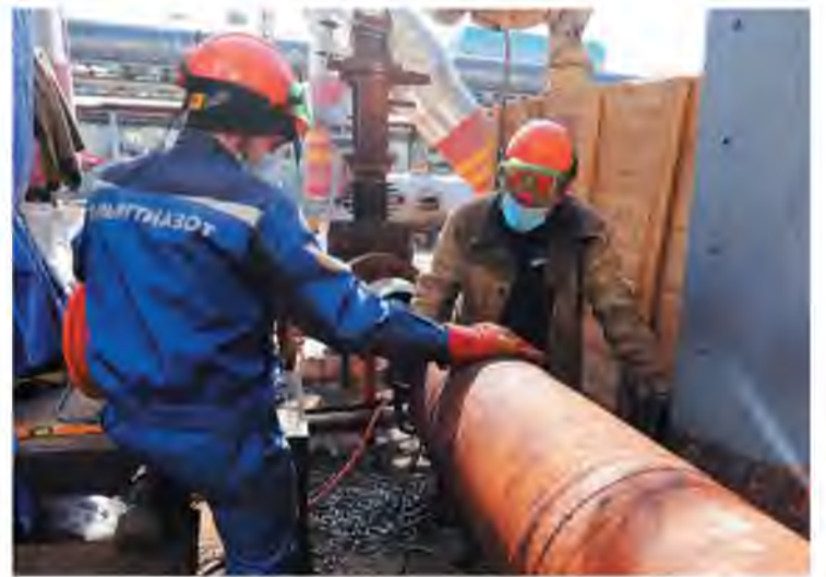
Идёт замена арматуры
